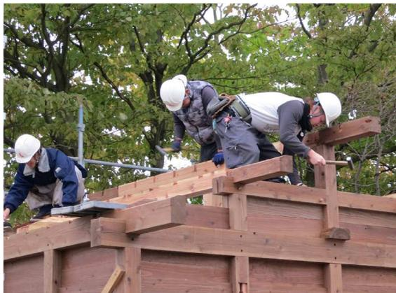
「大工実習講座 基礎編」は、木造建築の骨組(架構)を木組みでつくれる“建築大工の基礎技能”を実践的な実習で身につけます。
