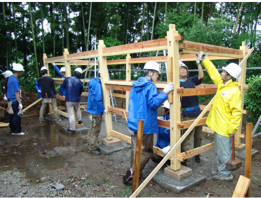
軸部組立て（建方）
