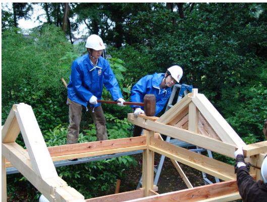
小屋組み組立て
